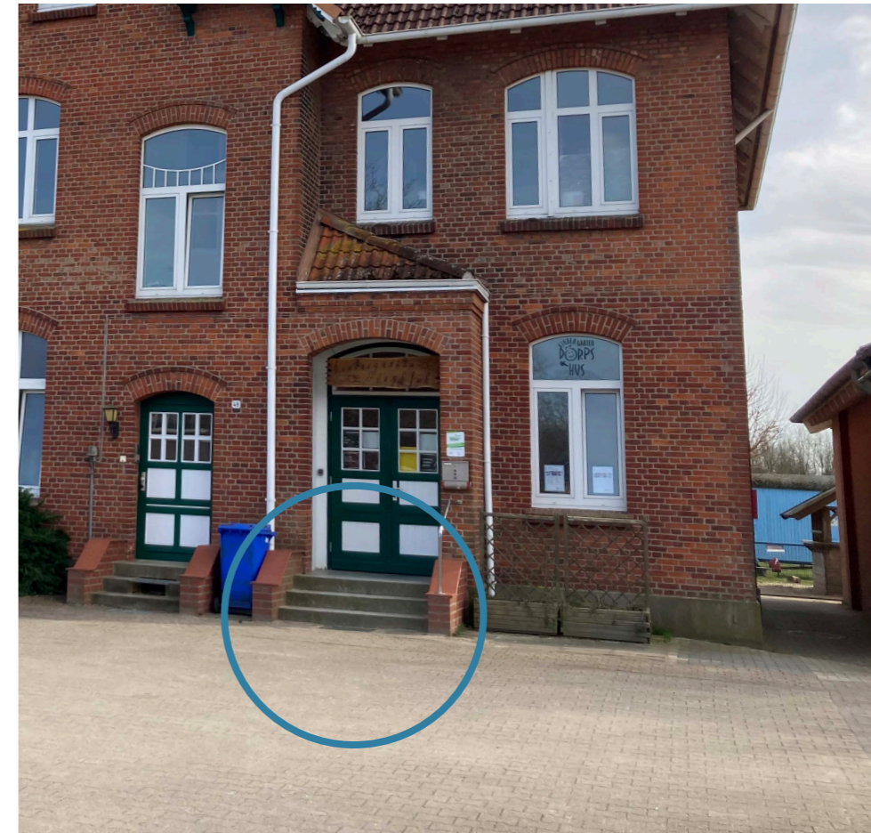
Foto: Zugang Kita (Treppenstufen)
